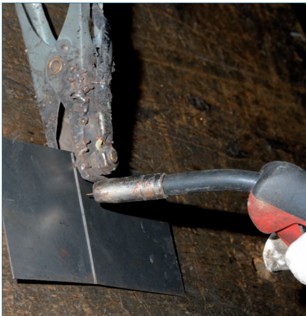
11.4. Posición de la pistola de soldadura.
